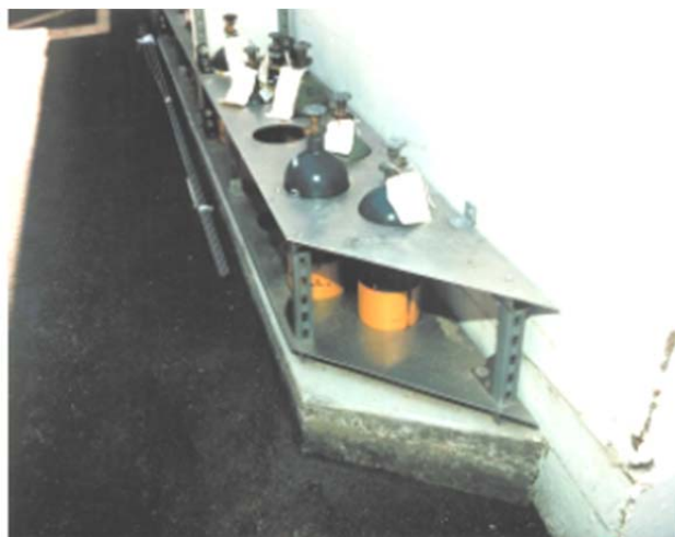
شکل ۵-۴۶- نگهدارنده سیلندرهای کوچک گاز
