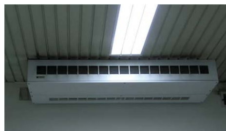
شکل ۱-۲۵- واحد تهویه مطبوع داخلی
