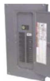
شکل ۱-۱۰۴- مرکز بار (نصب شده داخل دیوار)
