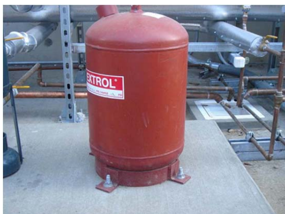
شکل ۵-۳۹- نمونه اجرا شده استفاده از نبشی برای تجهیزات با پایه مدور
