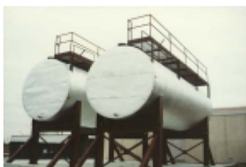
شکل ۷۵-۱- مخازن افقی
