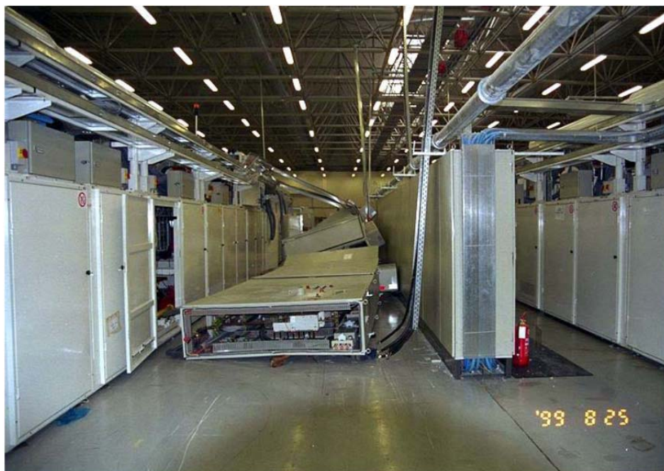
شکل پ ۲-۲۲- واژگونی کابین‌های الکتریکی مهار نشده در کارخانه تولید کاغذ در زلزله ۱۹۹۹ ازبیت ترکیه با بزرگای ۷/۴
